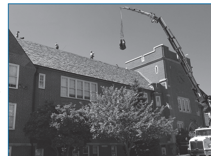
El distrito finalizó la primera fase del proyecto (construcción y reparación de techos) el verano pasado con un ahorro presupuestario de casi $1.2 millones.
